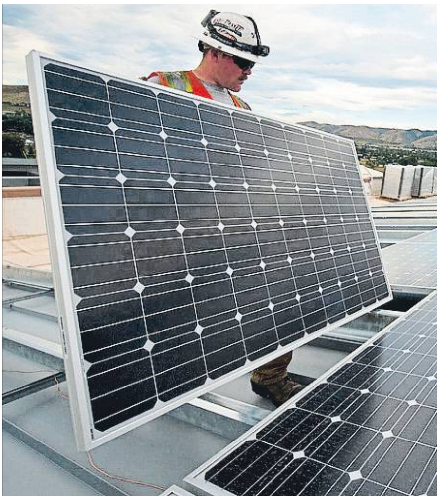
Un treballador subjecta una placa fotovoltaica
